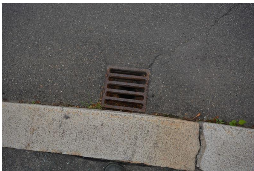
Detail odvodňovače u obruby L chodníku.
