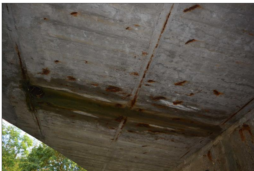
Detail podhledu NK mostu vlevo u OP2 u výústění odvodňovače.
