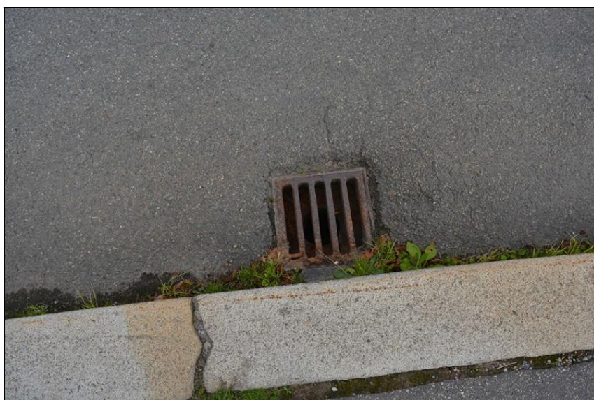
Detail odvodňovače u obruby P chodníku.
