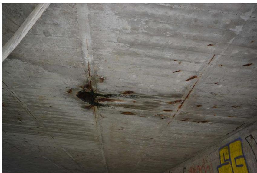
Detail pohledu NK mostu vpravo u OP2 u vyústění odvodňovače.
